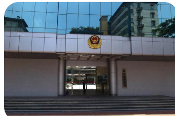
佛山市公安局IDC管理平台项目
