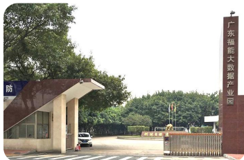
福能大数据机房项目
