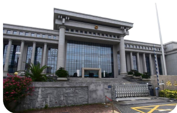
佛山市检察院维保项目
