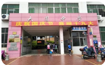
狮山镇大圃初级中学校园网设备项目
