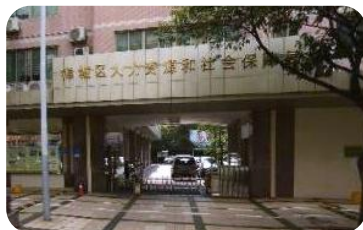
禅城区社保局维保项目
