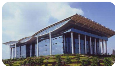
顺德行政服务中心大数据存储项目
